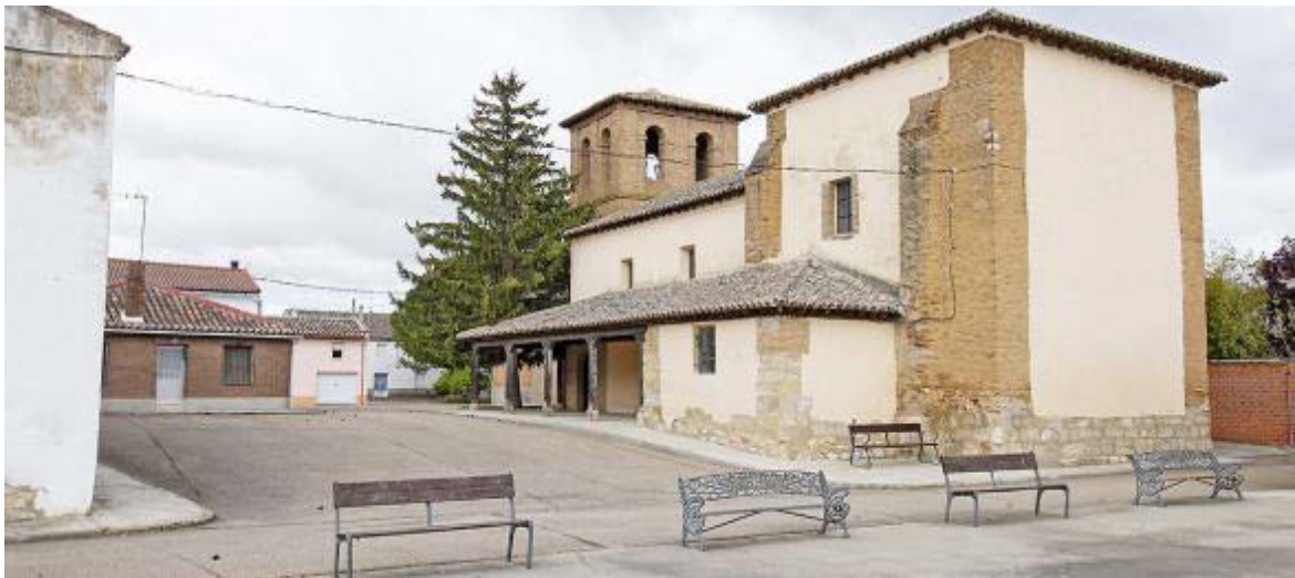
Las infraestructuras y los servicios serán mejorados.
