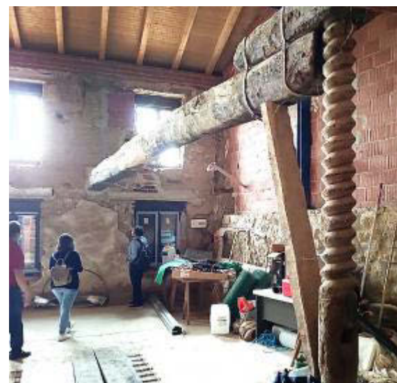
Esta es la vivienda incluida en el Plan Rehabilitare.
