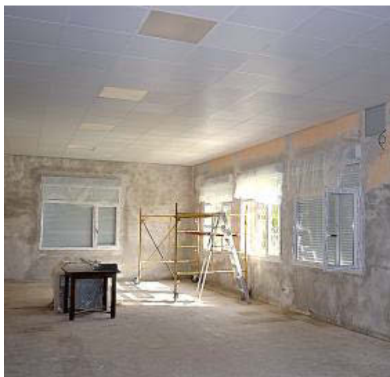
Son varias las obras de mejora que se han llevado a cabo.
