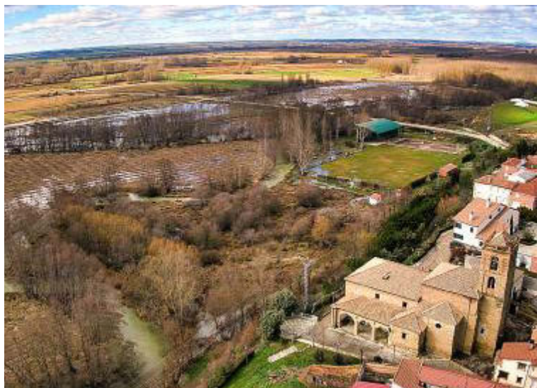
La iglesia de la Asunción es uno de los edificios más destacados. / DP
